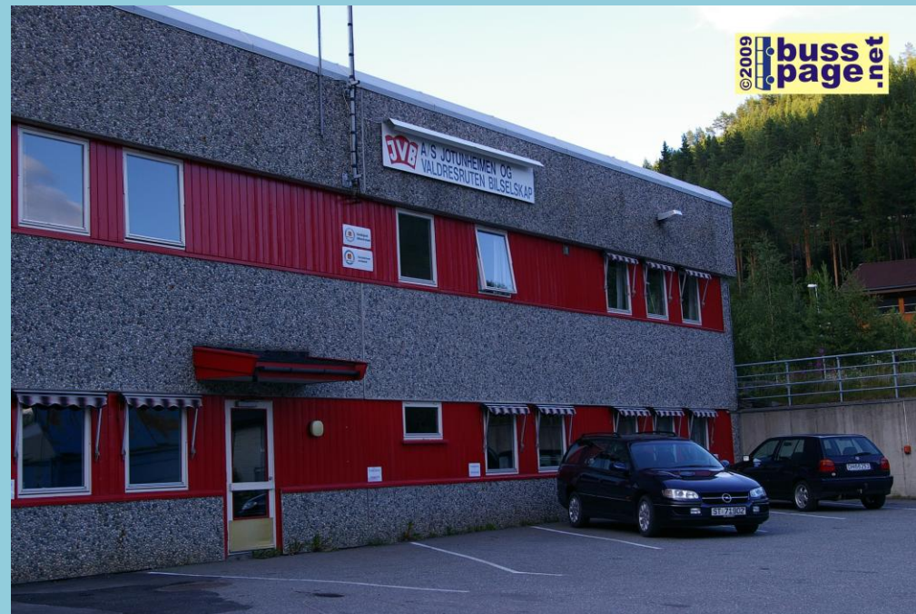
16.07.09 Kontoret og garasjen på Fagernes.
