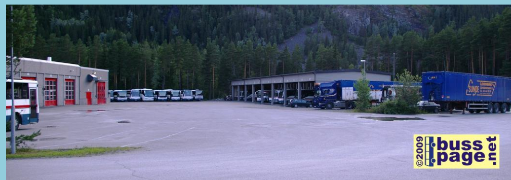
16.07.09 Kontoret og garasjen på Fagernes.
