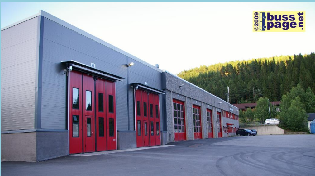
16.07.09 Kontoret og garasjen på Fagernes.
