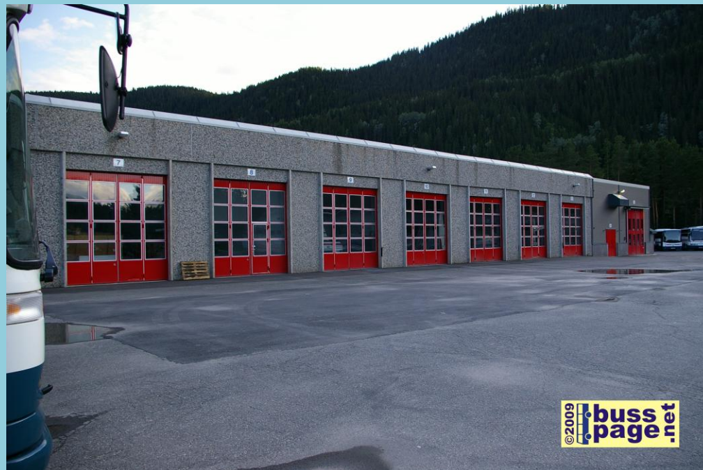
16.07.09 Kontoret og garasjen på Fagernes.
