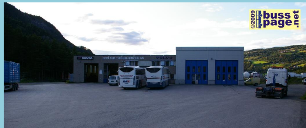
16.07.09 Kontoret og garasjen på Fagernes.
